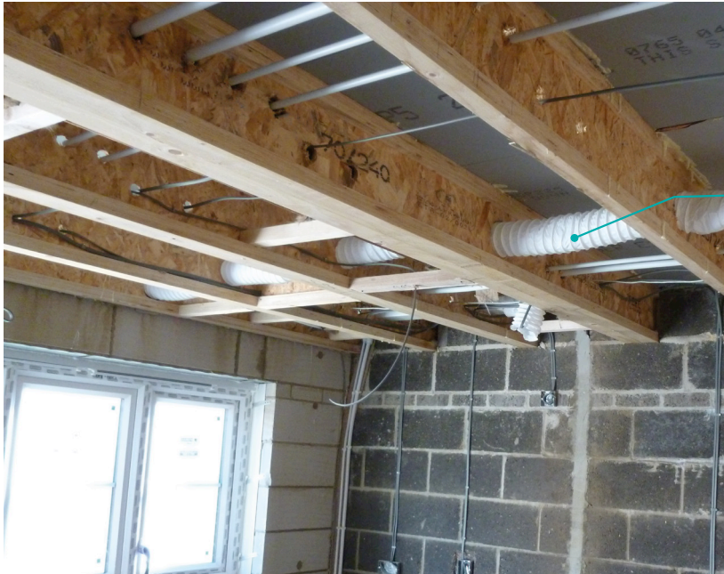
Figura 0.7 Con conductos flexibles demasiado largos y sueltos, los ventiladores serán ruidosos e ineficientes.
